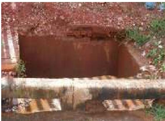
**Figura 76 - Boca de lobo sem tampa (sem manutenção)**
