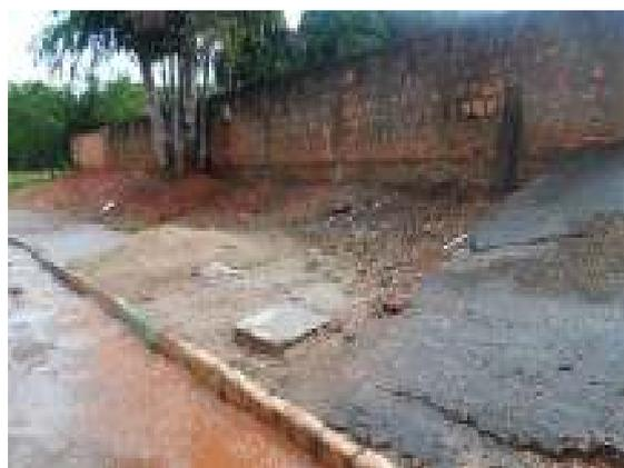
**Figura 73 - Via pavimentada sem escoamento**
