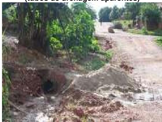
**Figura 71 - Erosão em via não pavimentada**
