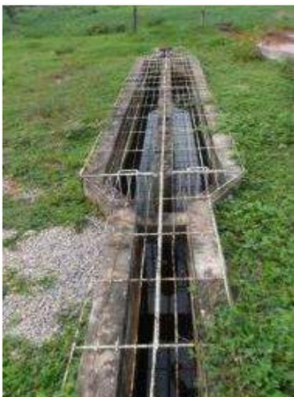
**Figura 59 - Sistema de Tratamento de Esgoto – Desarenador**
