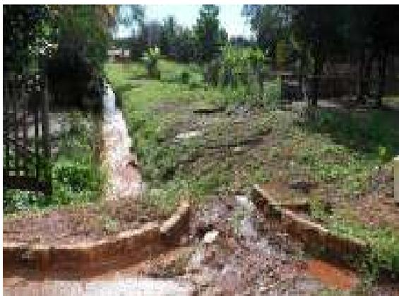
**Figura 68 - Início de erosão no final da via pavimentada**
