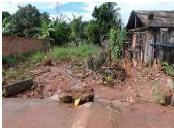
**Figura 75 - Erosão (necessidade de dissipador)**
