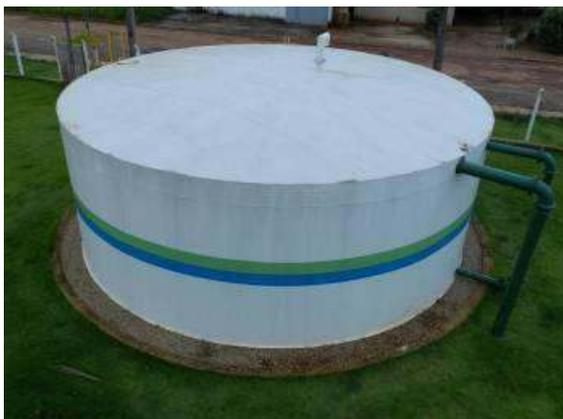
Figura 56 - Reservatório (capac. 200m<sup>3</sup>)
