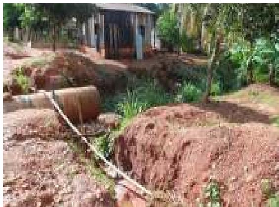
**Figura 69 - Erosão em via não pavimentada (tubos de drenagem aparentes)**
