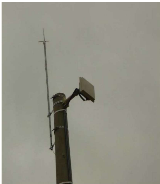
Figura 15: Sistema de fixação suporte Radio
