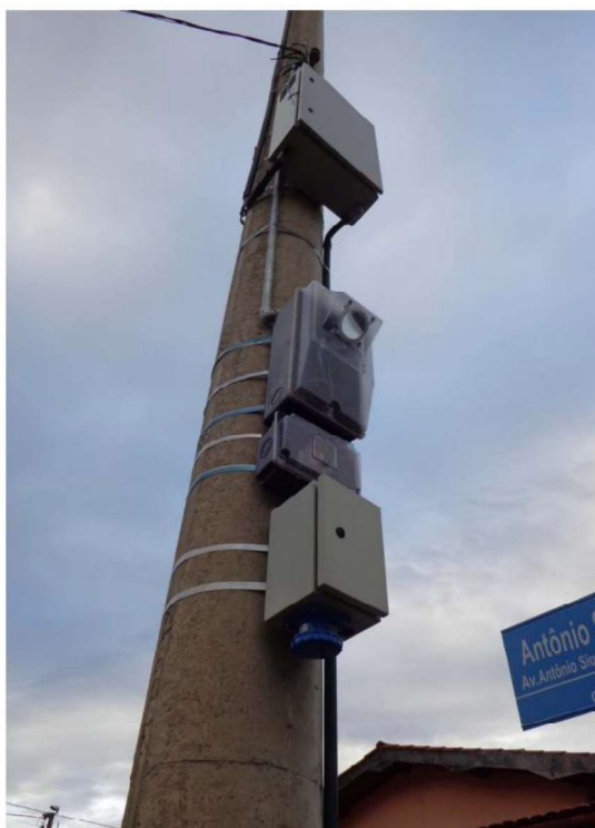
Figura 6.1 – Caixa de Medição
