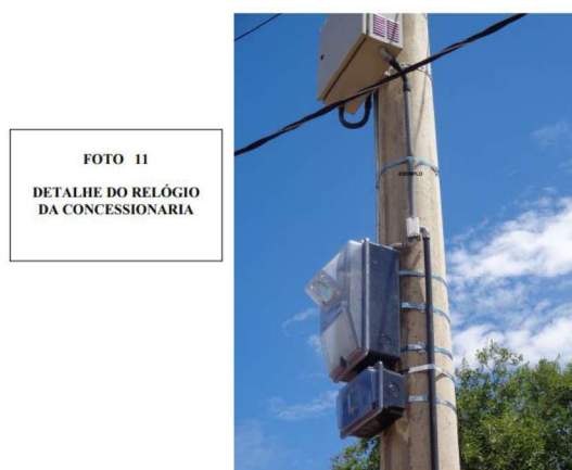
Figura 13: Exemplo do detalhe do relógio da concessionária
