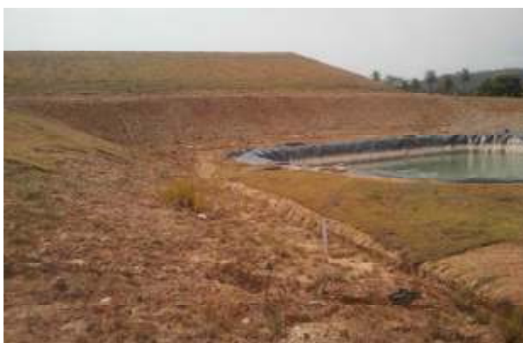
Conformação do barranco da Lagoa anaeróbia para plantio de grama
