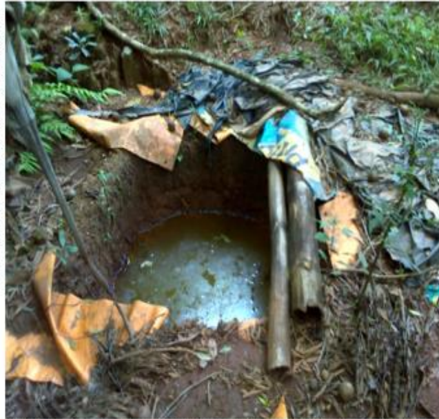
Figura 4.3. Esgotamento sanitário através de “fossa rudimentar” em domicílio rural da comunidade de Maquiné, distrito de Ravena, Município de Sabará-MG.
