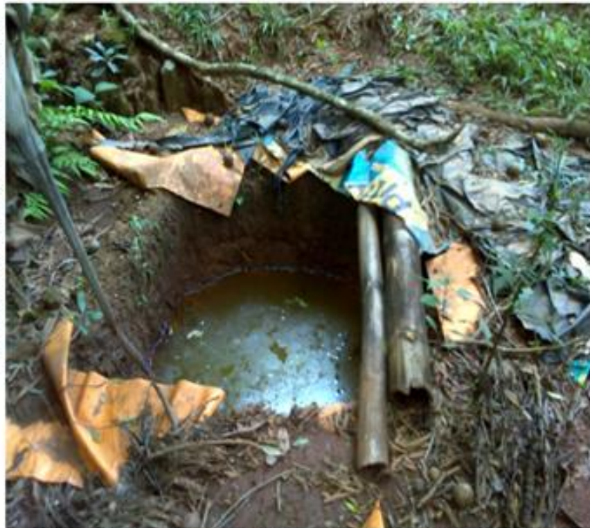
Figura 4.3. Esgotamento sanitário através de “fossa rudimentar” em domicílio rural da comunidade de Maquiné, distrito de Ravena, Município de Sabará-MG.
