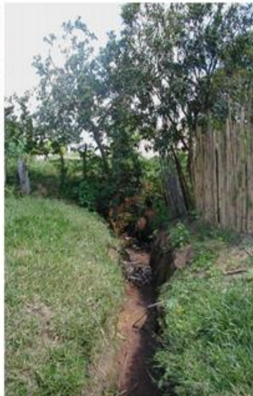
Figura 4.4. Esgotamento sanitário através de “vala” de domicílio rural do Município de Lagoa da Prata-MG em janeiro de 2002.
