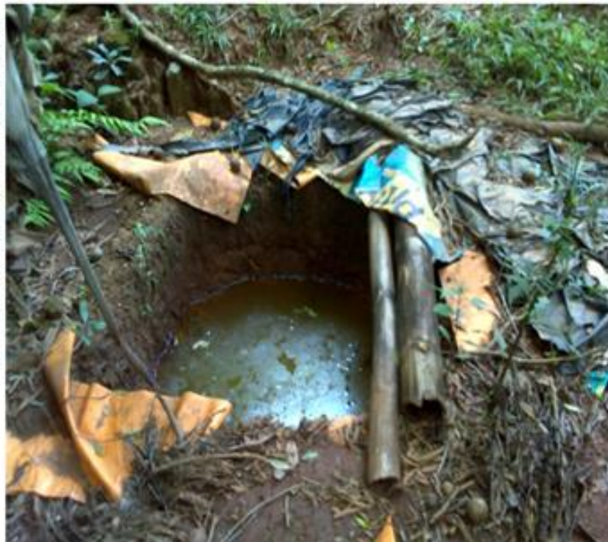
Figura 4.3. Esgotamento sanitário através de “fossa rudimentar” em domicílio rural da comunidade de Maquinê, distrito de Ravena, Município de Sabará-MG.
